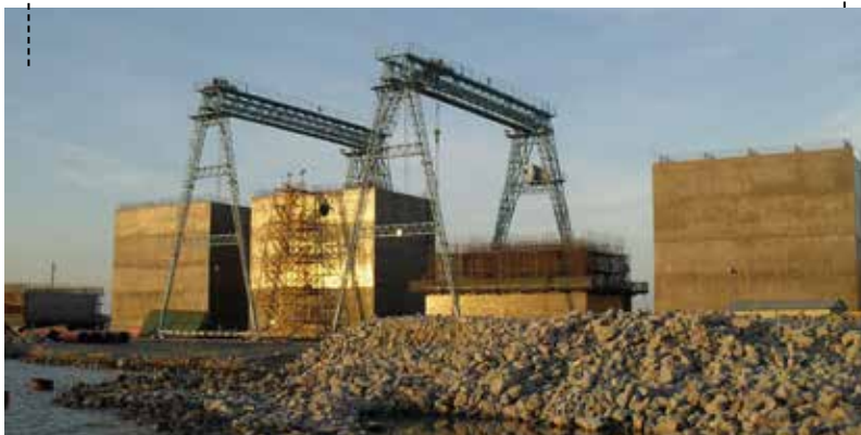
PRÉ-FABRICAÇÃO DOS CAIXOTÕES
