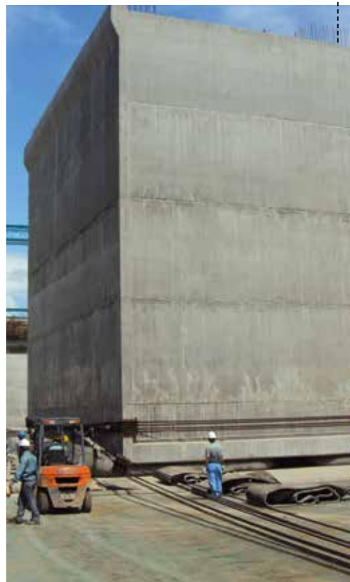
PRÉ-FABRICAÇÃO DOS CAIXOTÕES
