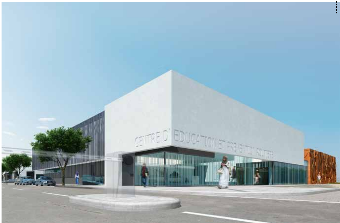
VISTA DA ENTRADA PRINCIPAL
