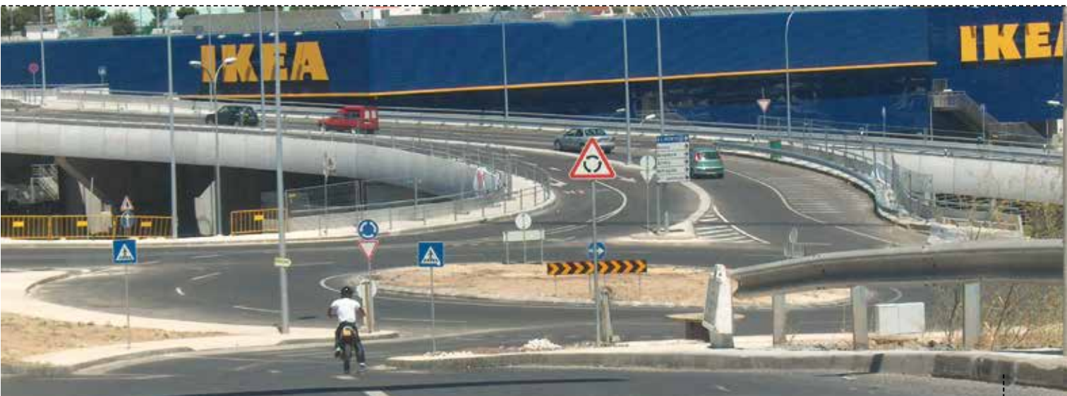
VIADUTO DA IKEA
