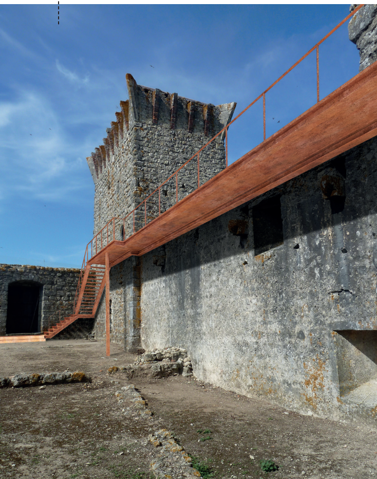
PASSADIÇO DE LIGAÇÃO ÀS TORRES
