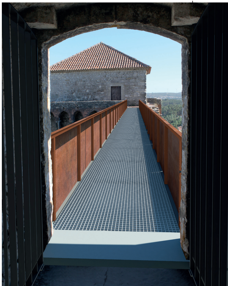
PASSADIÇO DE LIGAÇÃO AO TORREÃO
