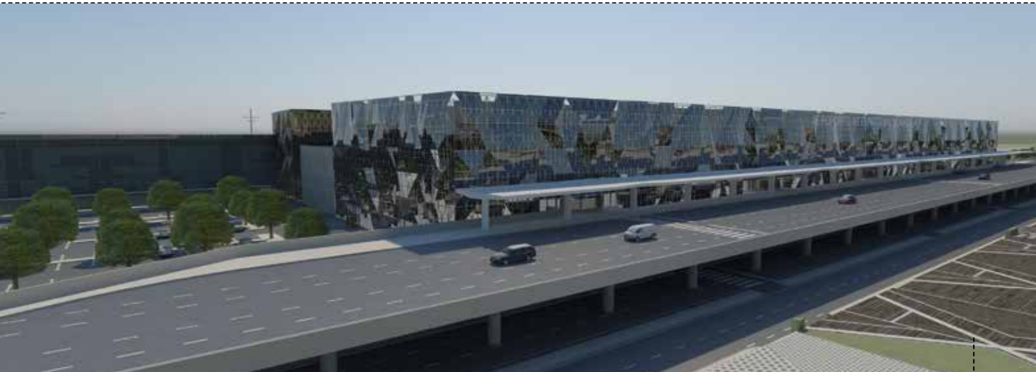
TERMINAL DE PASSAGEIROS
