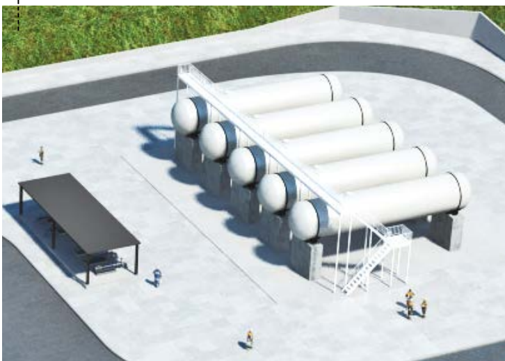
PORMENOR DE DEPÓSITOS DE GÁS
