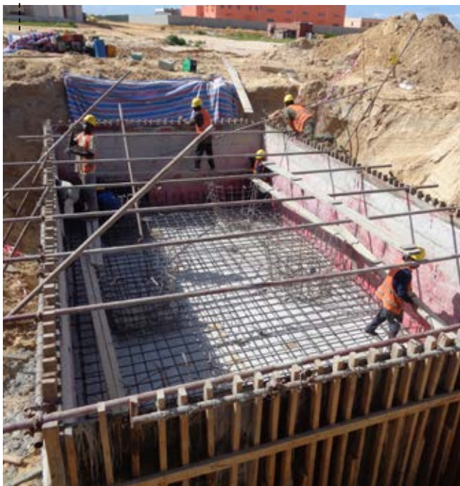
MACIÇO DE ENCABEÇAMENTO DE ESTACAS
