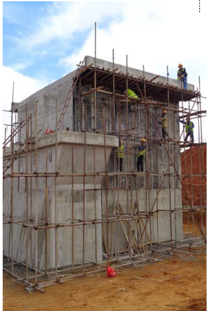
ENCONTRO DE VIADUTO
