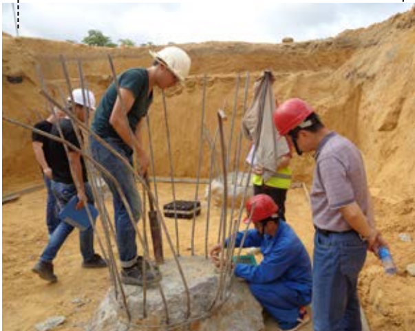
SANEAMENTO DE ESTACA
