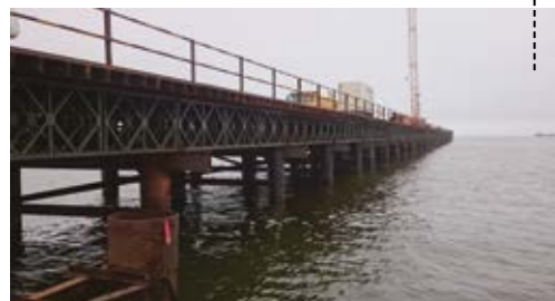
TRABALHOS DE CONSTRUÇÃO DO VIADUTO E DA ZONA DE ATRACAGEM
