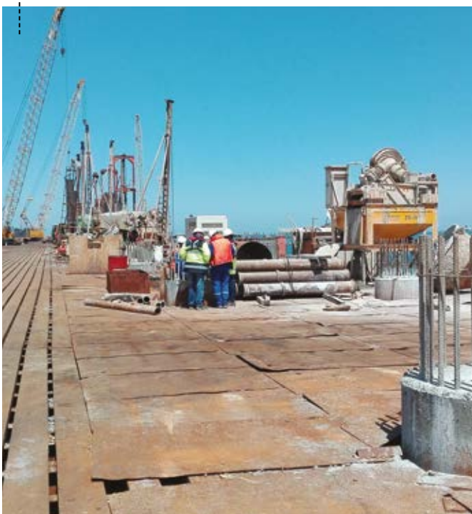
TRABALHOS DE CONSTRUÇÃO
