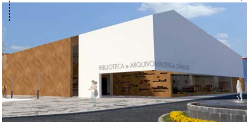
VISTA DA ENTRADA PRINCIPAL
