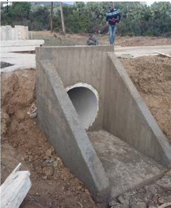
VISTA DE PASSAGEM HIDRÁULICA COM MUROS DE ALA
