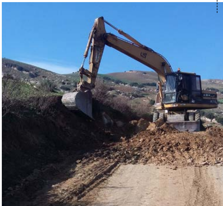
INÍCIO DOS TRABALHOS DE REABILITAÇÃO
