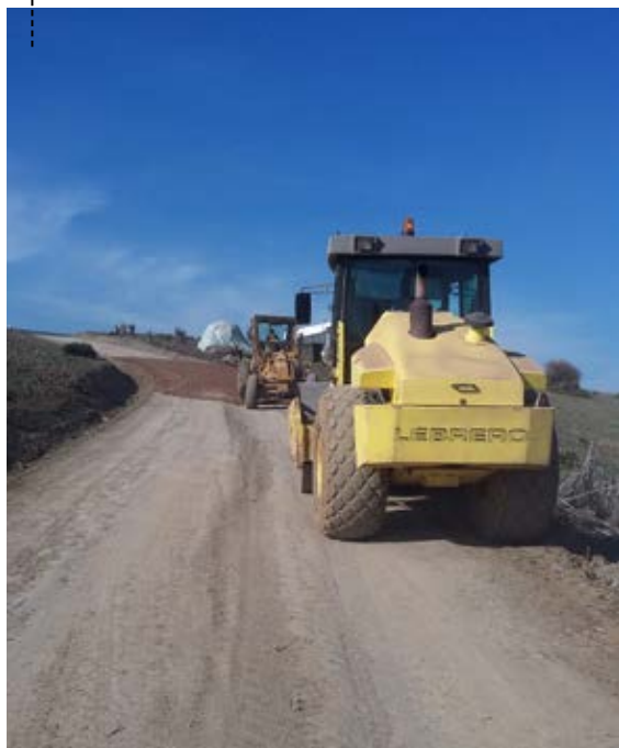
INÍCIO DOS TRABALHOS DE REABILITAÇÃO
