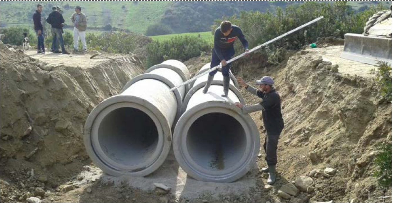
MONTAGEM DE PASSAGEM HIDRÁULICA
