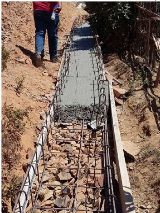
CONSTRUÇÃO DE UM CANAL DE IRRIGAÇÃO
