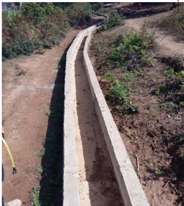
CANAL DE IRRIGAÇÃO CONSTRUÍDO
