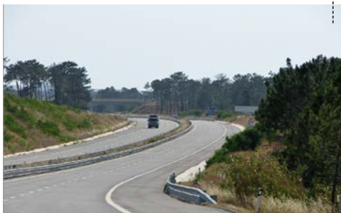
VISTA PARCIAL DA SUBCONCESSÃO
