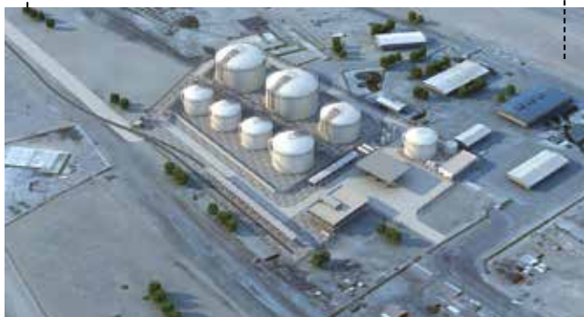
VISTA AÉREA DO TANK FARM
