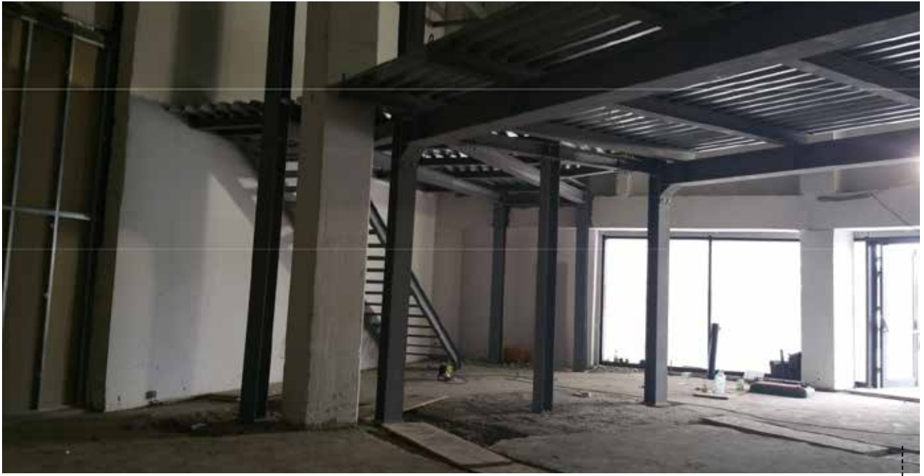
OBRA DE CONSTRUÇÃO
