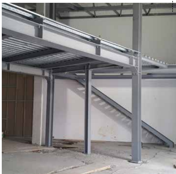
OBRAS DE CONSTRUÇÃO
