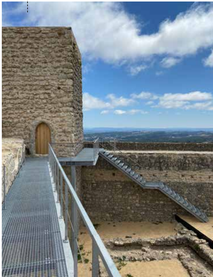
PASSADIÇO DE LIGAÇÃO E ESCADAS DE ACESSO
