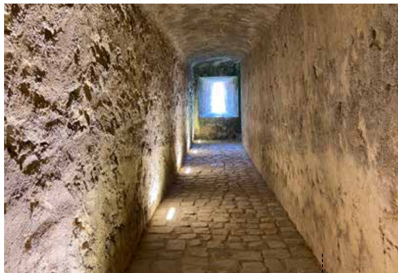
VISTA DA PASSAGEM INTERVENCIONADA
