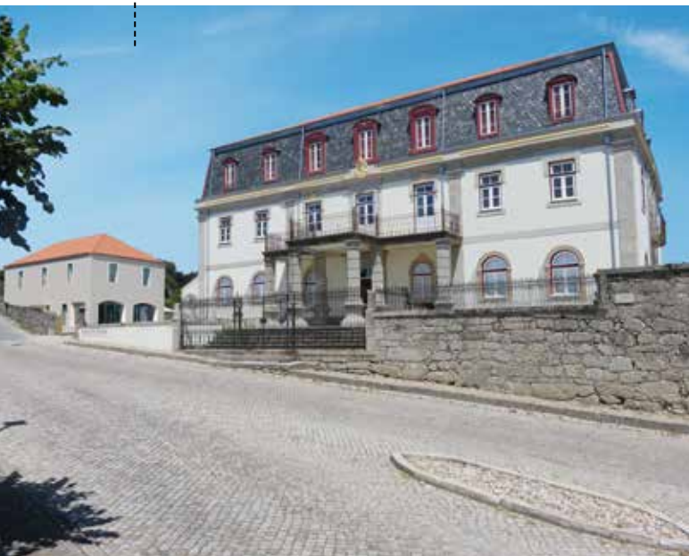
VISTA DO ACESSO PRINCIPAL
