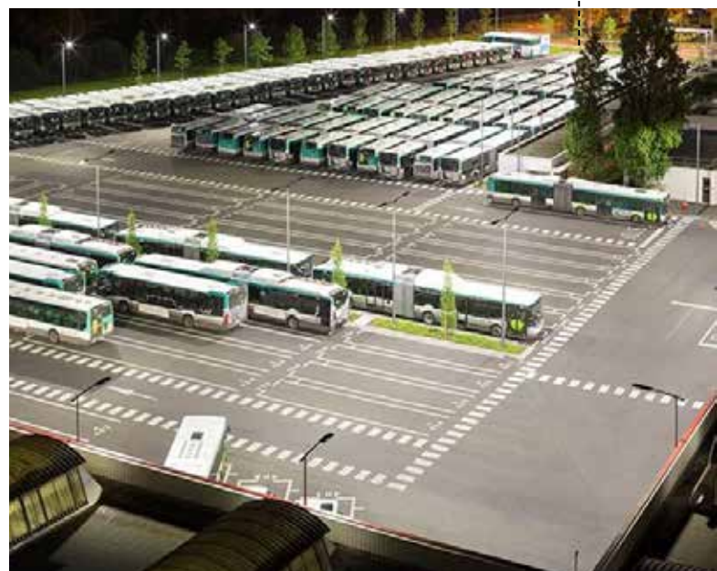
VISTA DA ZONA DE ESTACIONAMENTO PARA AUTOCARROS
