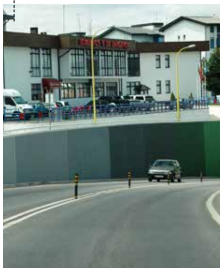
INÍCIO DO DESNIVELAMENTO
