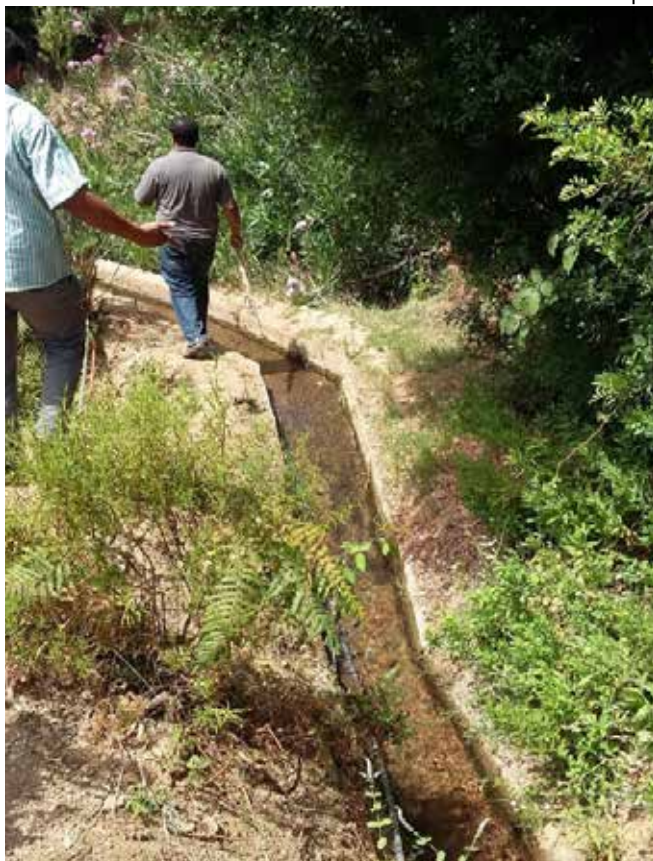
DIAGNÓSTICO DE UM CANAL DE IRRIGAÇÃO EXISTENTE
