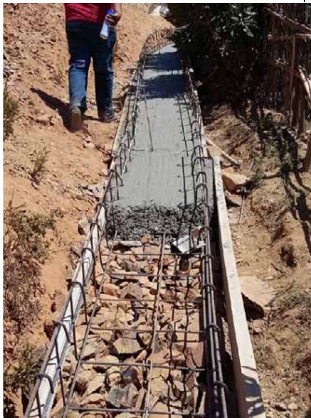
CONSTRUÇÃO DE UM CANAL DE IRRIGAÇÃO
