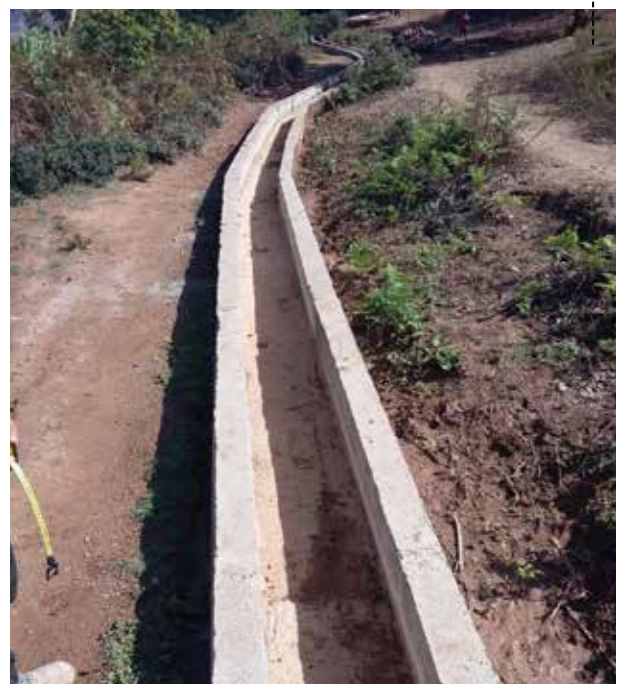
CANAL DE IRRIGAÇÃO CONSTRUÍDO
