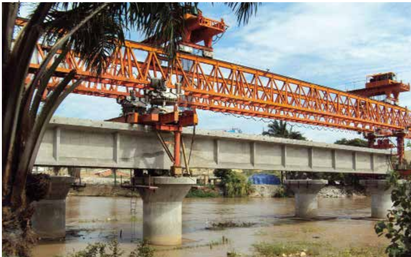
PONTE DA CATUMBELA
