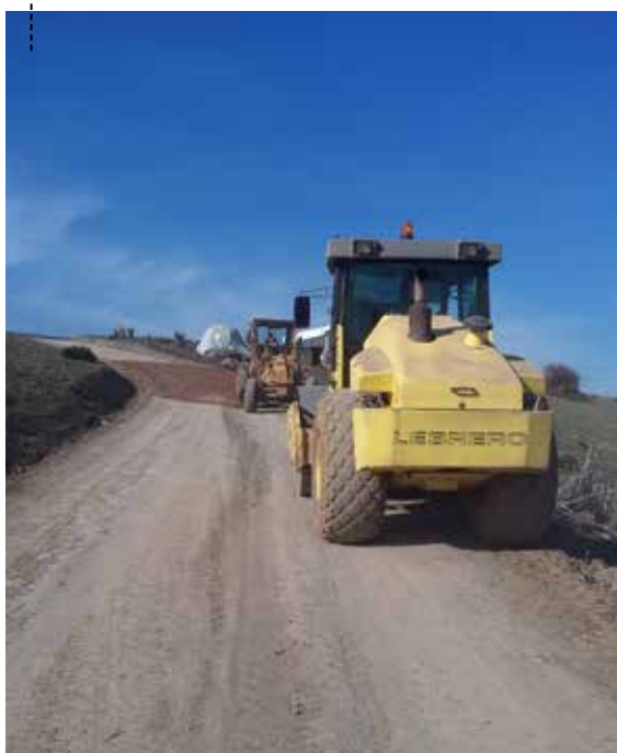
INÍCIO DOS TRABALHOS DE REABILITAÇÃO
