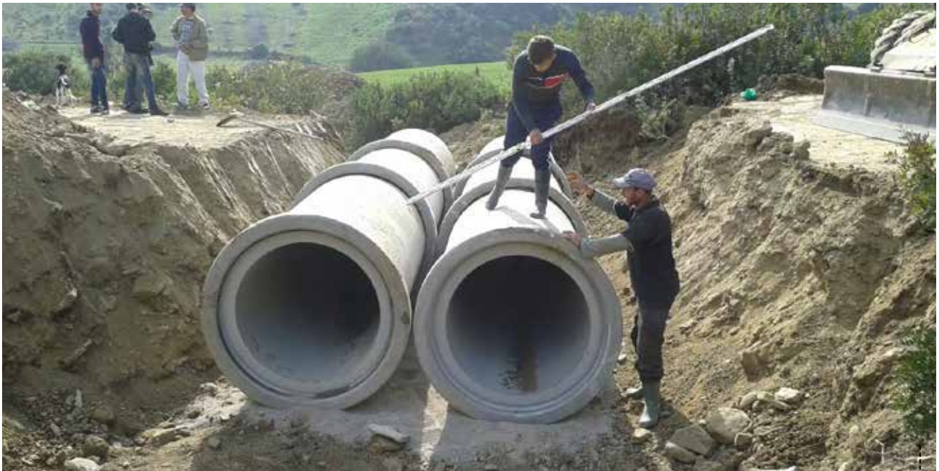
MONTAGEM DE PASSAGEM HIDRÁLICA
