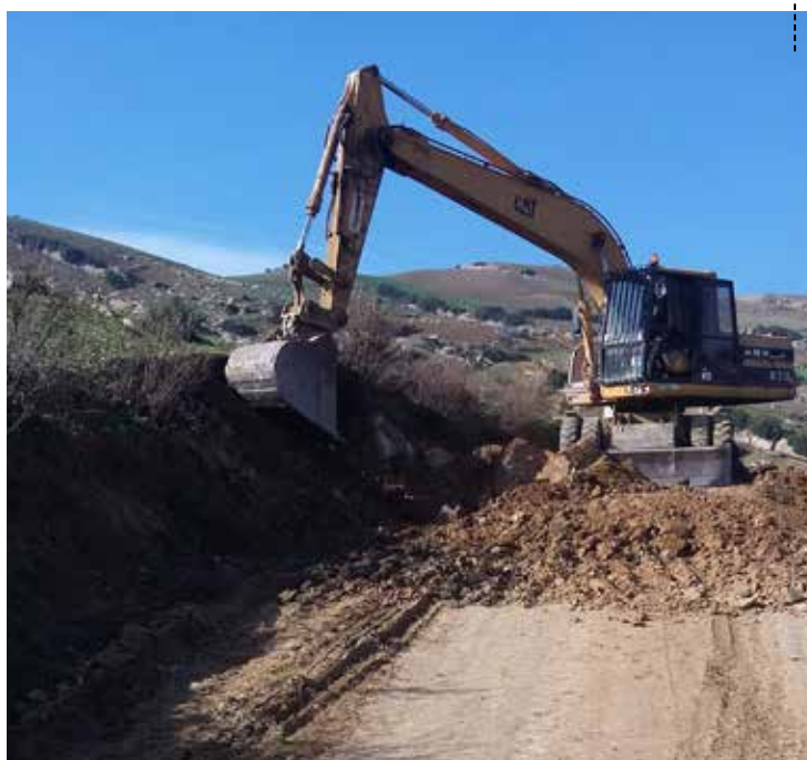
INÍCIO DOS TRABALHOS DE REABILITAÇÃO
