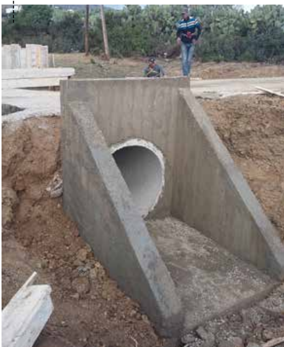
VISTA DE PASSAGEM HIDRÁLICA COM MUROS DE ALA
