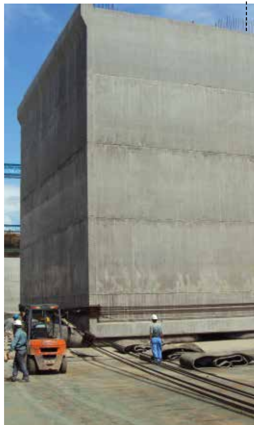
PRÉ-FABRICAÇÃO DOS CAIXOTÕES
