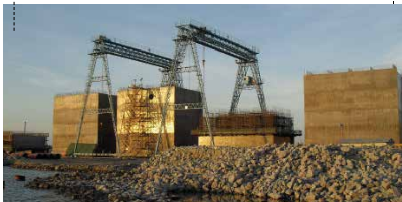
PRÉ-FABRICAÇÃO DOS CAIXOTÕES
